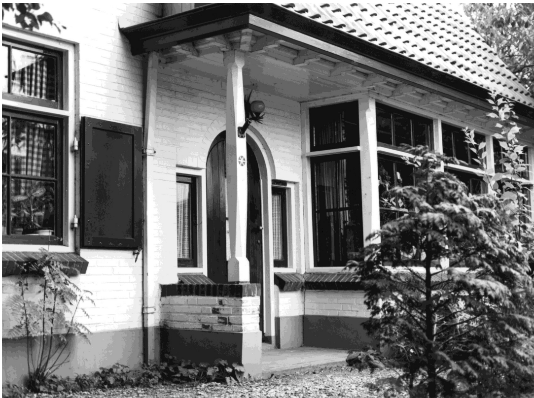
<< De entree voordat het verzakkingsproces begon, het zag er allemaal nog strak uit.
